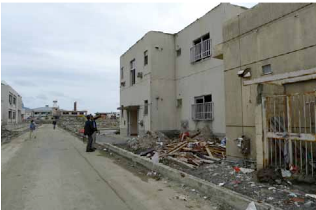
⑤建物状況：大船渡警察署高田幹部交番宿舎 低層でも RC 建物は残っているが、屋上まで浸水（撮影：伊藤）
