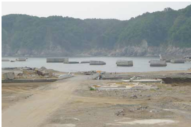
⑤漁港を囲んでいた防波堤 バラバラに流され、基礎から転倒している (撮影：伊藤)
