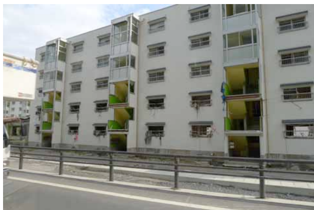
⑤雇用促進住宅片岸宿舎 5階建ての2階まで浸水跡が見られるが、躯体は損傷軽微(その後、全棟取り壊しが決定している：6/24に取り壊しの入札公告)。市北端に位置する。(釜石市片岸) (撮影：伊藤)
