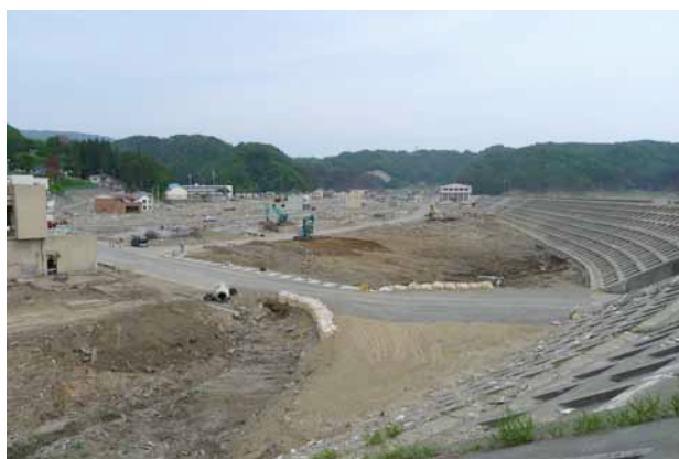
①～②陸側の堤防 高さ 10m の堤防の内部に津波が侵入、市街地のほぼ全ての建物が流失した (撮影：伊藤)
