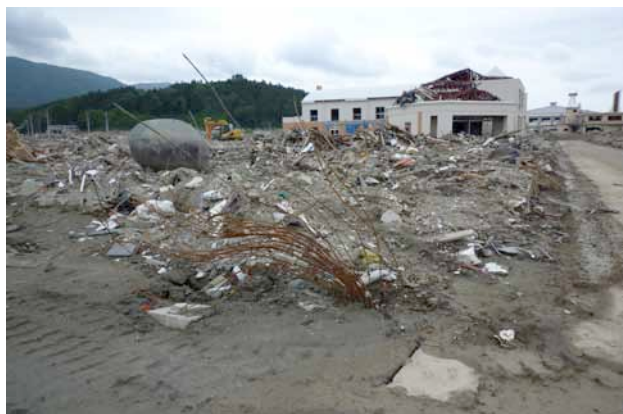
③市役所周辺 RCの柱が根こそぎ津波に持っていかれ、鉄筋のみが残る (撮影：中川)
