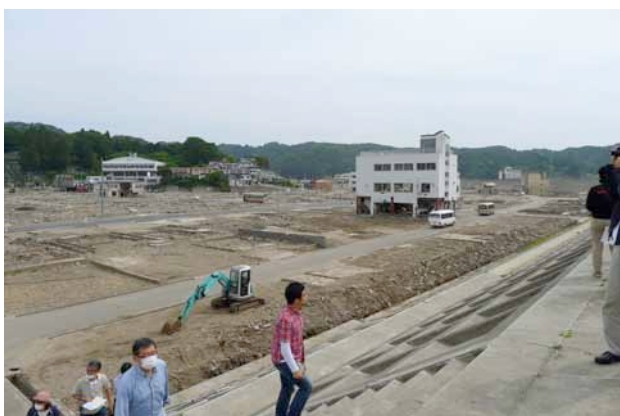
①～②陸側の堤防 高さ 10m の堤防の内部に津波が侵入、市街地のほぼ全ての建物が流失した (撮影：伊藤)
