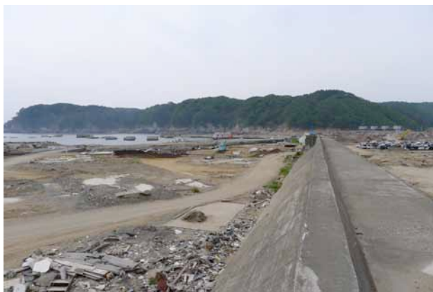
④海側の南側堤防 健在だが、津波は容易に乗り越えた (撮影：伊藤)
