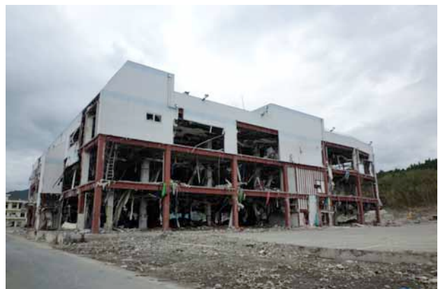
④マイヤ高田店(スーパー) 鉄骨がむき出しになっている (撮影：中川)
