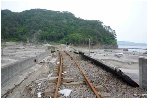
① 高架にあった三陸鉄道北リアス線島越駅ごと線路が流失（撮影：中川）
