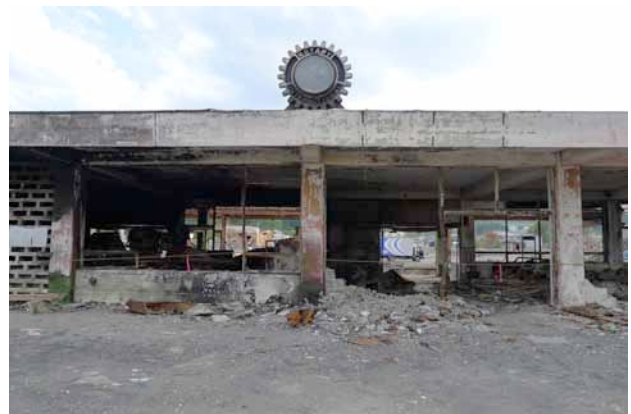
③～④JR 山田線陸中山田駅 津波後の火災で壁が黒くこげている。周辺の建物も火災の痕が見られる (撮影：伊藤)
