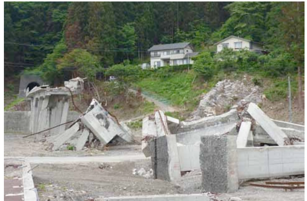
② 橋脚は倒壊 基礎がむき出しになっており、洗掘破壊の様子が見て取れる（撮影：中川）
