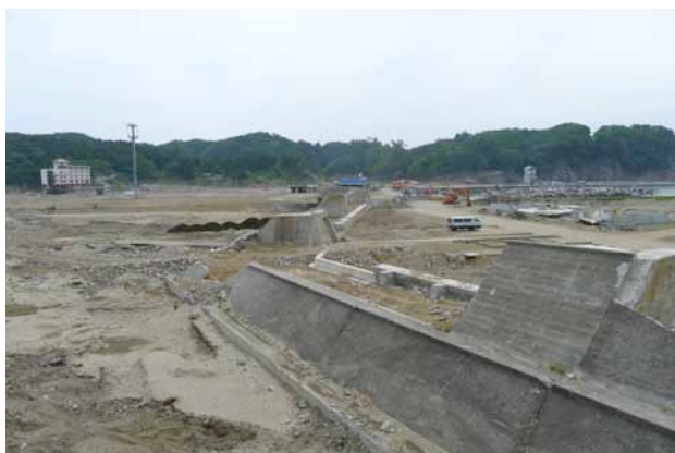
③海側の北側堤防 津波により破壊 (撮影：伊藤)
