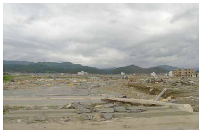
⑧海岸付近の状況（撮影：伊藤）
