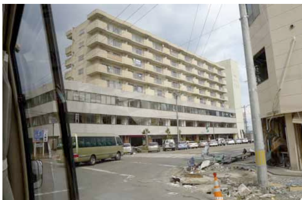
④市営釜石ビル 昭和57年建築 8階建 3階までは事務所等、上階は市営住宅(40戸)。釜石市の指定する津波避難ビル2棟のうちの1棟であり、実際に津波時に避難された方もいる(浜町1丁目1-1) (撮影：伊藤)
