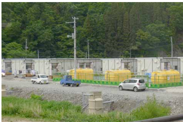
⑦高台に建設された仮設住宅 非常に密集して建てられている (撮影：伊藤)
