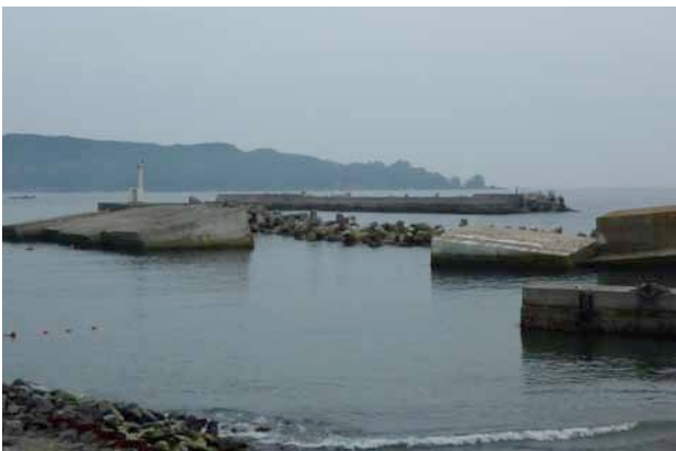
③ 漁港の防波堤は転倒、流失（撮影：中川）
