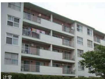
辻堂 バルコニー凹面塗装の例。フレームのよさが光り、街並みに奥行き感を出しています。
